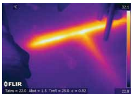
Esta imagen térmica muestra dónde se ha instalado la tubería de agua caliente bajo el suelo.
