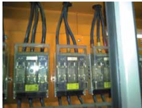
La inspección de unos cables eléctricos revela la existencia de anomalías eléctricas, al examinar unos cables contiguos a unos fusibles protegidos por plexiglás. Gracias a MeterLink, los valores leídos por la pinza amperimétrica se indican en la imagen térmica.
